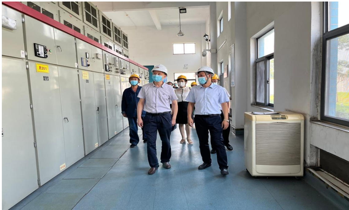
图 11 实地参观了天通电力产业学院月台变电站实训基地
